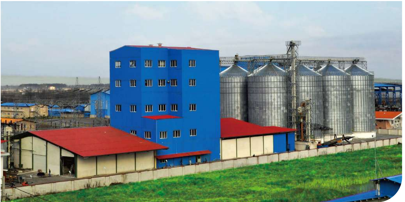
شرکت سپید ماکیان؛ خط تولید خوراک طیور به ظرفیت ۳۰ تن در ساعت و ۲۰ هزار تن سیلوی فلزی.
